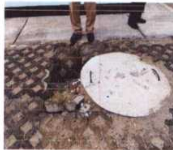
Monev Pembangunan Sumur Resapan di Terminal Semin
